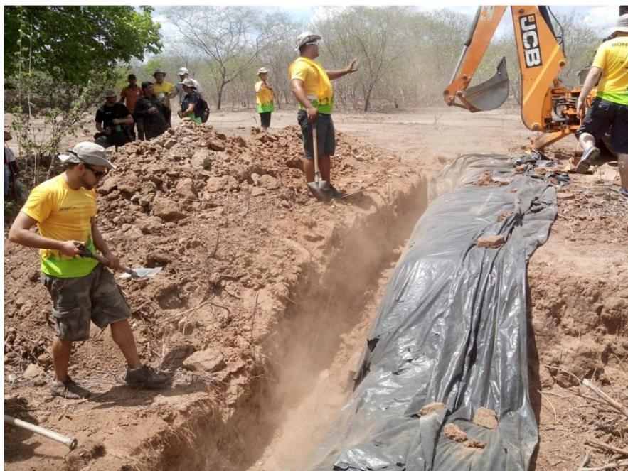
Figura 4 instalação da lona plástica e fechamento da trincheira.
