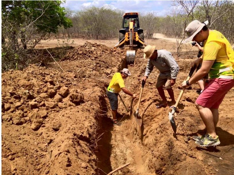
Figura 3 Limpeza da trincheira.
