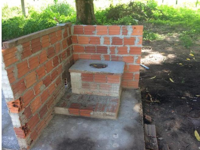
Figura 3: Paredes levantadas e assento finalizado. Fonte: Autora
