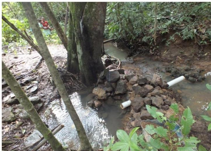
Figura 7 - Reservatório de captação - Acervo Núcleo Extensionista Rondon IFPR, Campus Palmas.
