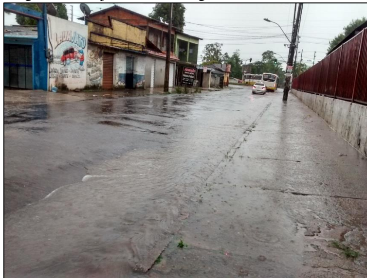
Figura 5 – Sarjetas sobrecarregadas no bairro do Tenoné
