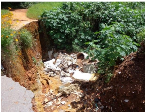
Figura 2: Resíduos sólidos próximos ao Córrego Tamanduá
