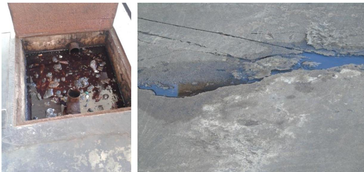
Figura 2 – Duas imagens referentes respectivamente ao Posto 1 e 4 nas quais se observa uma caixa separadora de água e óleo suja, o que reduz sua eficiência, e rachaduras no piso da pista de abastecimento favorecendo situações de contaminação ambiental.
