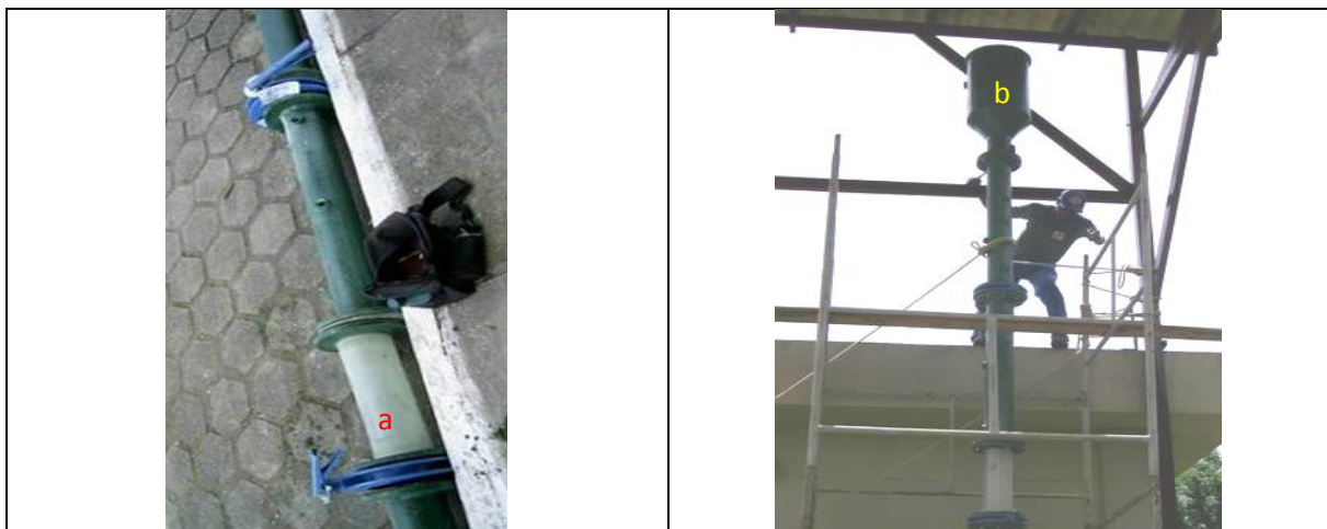
Figura 3. Fotografias dos reatores. a) Módulo para introdução de oxigênio; b) Localização e montagem do RHANA.
